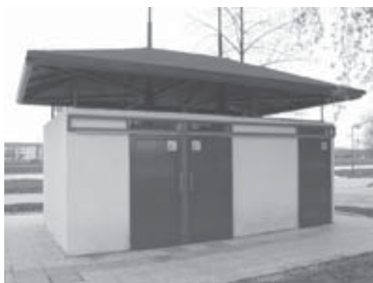
Tualete të aksesueshme pranë tualeteve të zakonshme
