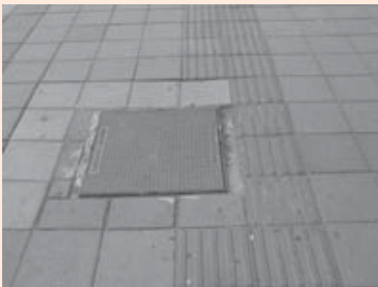
Manhole built on textPlatformë e ndërtuar në Beogradin e
