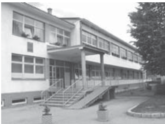
Shkollë me platformë të pjerrët por pa asgjë të aksesueshme në brendësi të ndërtesës. Gorazhde, B-H
