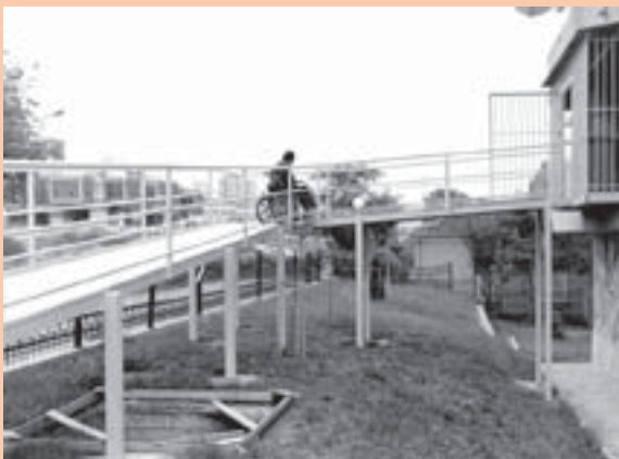
Platformë e pjerrët, e gjerë, e ndërtuar jashtë shtëpisë së Farukut në provincën e Kosovës, të administruar nga OKB
