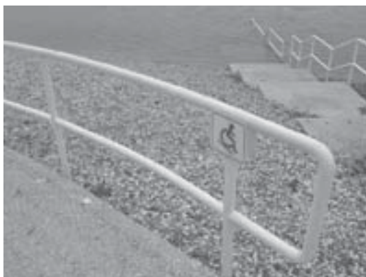
Platformë e pjerrët nga plazhi drejt ujit
